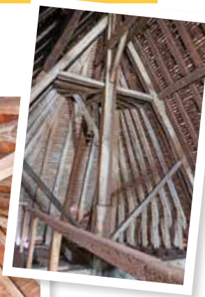
Charpente du chœur ▲
