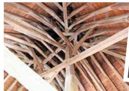
Charpente du clocher ▼
