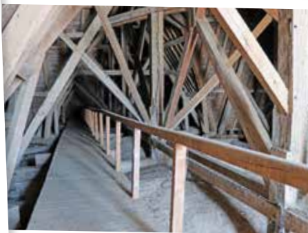
Charpente nef, vers le du chœur
